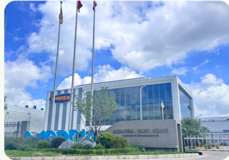
张家港电子科技工厂
